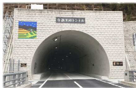
合瀬耳納トンネル
